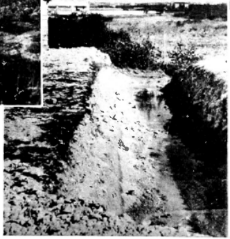
Zanja abierta para poner en comunicación con el mar un gran criadero de mosquitos, lo cual permitió el control del mismo.
